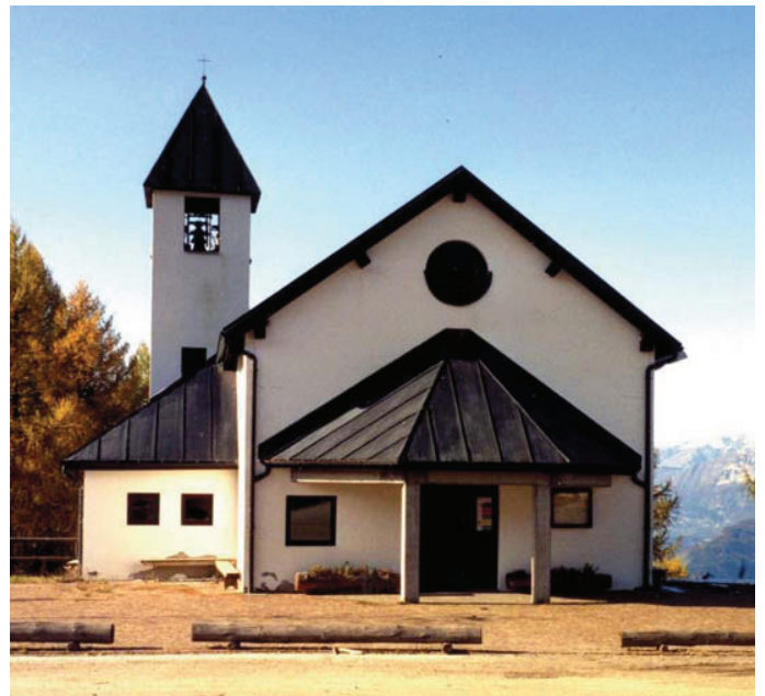
Im Ortsteil Kamaovrunt die Kirche zur Madonna des Friedens, die im Jahr 1984 erbaut wurde
