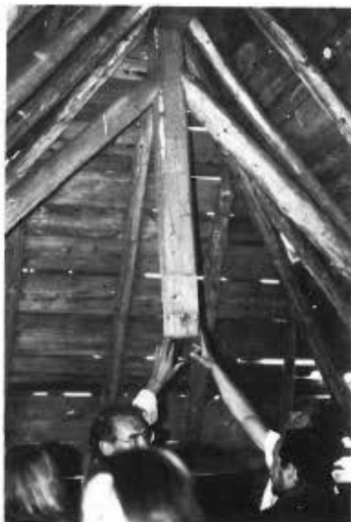
„Manazzo-Alm“ bei der Cima Larice (VII Gemeinden) Dachkonstruktion mit Hängebalken
